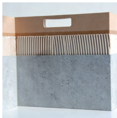
▲ Montage Vollflächig im 1 oder 2-K Kleberbett
